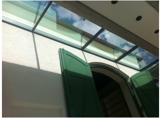
Anschluss Neuau an Bestand
